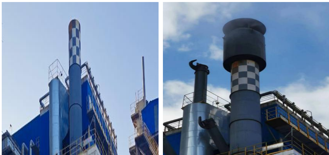
哈尔滨市某企业煤磨烟筒加装消音器前后对比
