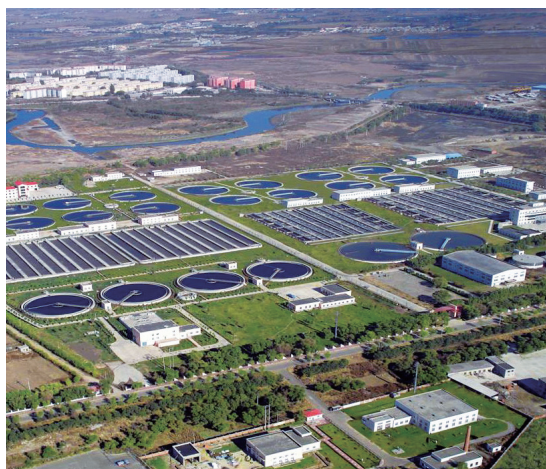
城市污水处理厂全景图
